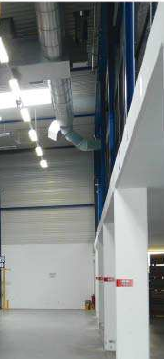
Mit dem Lagerverwaltungssystem von aisys erzeugt Linnemann-Schnetzer automatische Lagerprozesse und reduziert Bewegungen der Verschieberegale.
